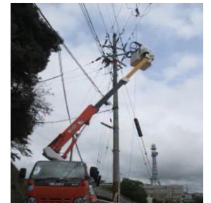
配電線の点検
