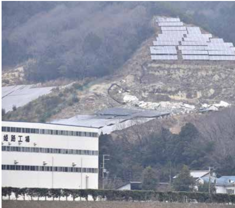
土砂災害で太陽光パネルが崩落し、むき出しになった斜面 兵庫県姫路市で 写真提供：読売新聞社
