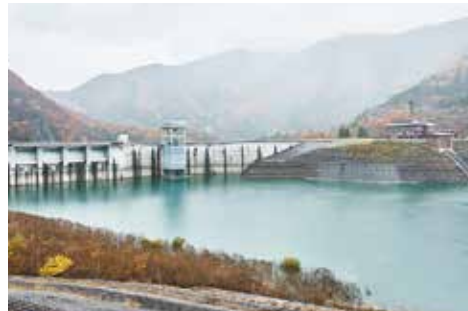
大内ダム(上池)の構造はロックフィルダム。法面の緑化など周囲の自然環境に配慮した造りになっています。
