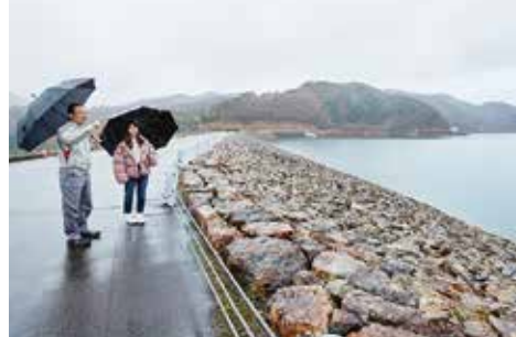
大内ダム(上池)の構造はロックフィルダム。法面の緑化など周囲の自然環境に配慮した造りになっています。
