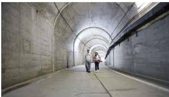
搬入路トンネルの奥、地下60mの位置に下郷発電所があります。
