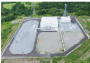
北斗変換所の全景。中央上部の大きな建物がバルブホール。右側が直流開閉装置、左側が交流開閉装置。
