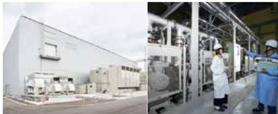
新設するFCの建屋は外壁材と屋根材を同じにし、コンクリートの養生期間不足による冬季のひび割れ対策としてガルバリウム鋼板を使用。運転中のサイリスタバルブの熱を除く冷却装置。寒冷地のため冷却水は不凍液を使用している。
