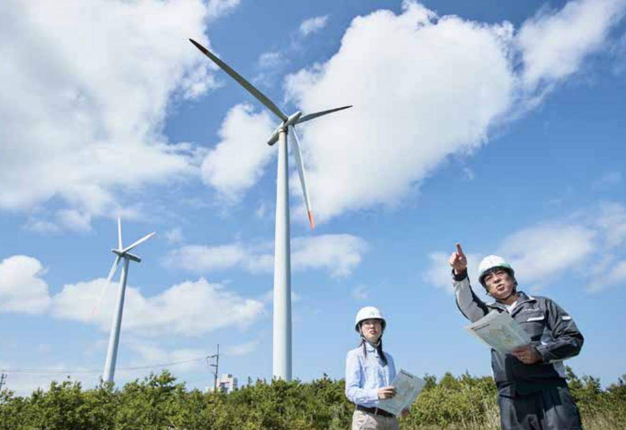
出力1300kWの風車を10基設置しているユース小田野沢ウインドファーム。ご案内いただいた相馬さん(右)と戸田さん(左)。
