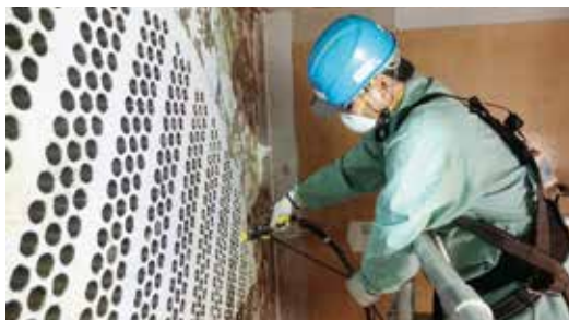
復水器細管の内部の点検 (約27,000本の細管全数の健全性を確認)
