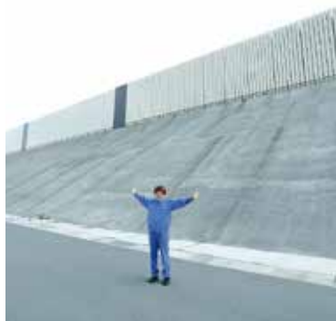
3年前の取材のときには建設工事真っ最中だった防潮堤が完成していました。あらためてその高さと長さに圧倒されました
