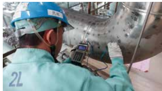
超音波厚さ測定器による配管の肉厚測定 (配管約170カ所を検査)
