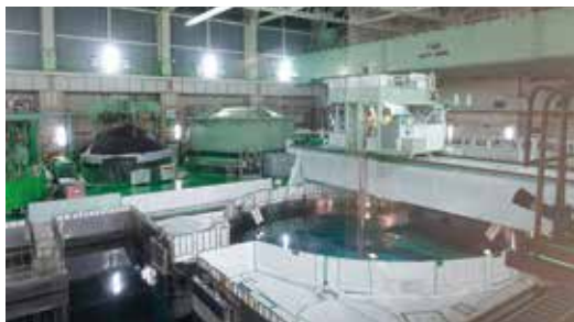
燃料交換機を使用した燃料集合体の取り替え (560体中80体を新燃料に取り替え)
