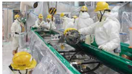
制御棒駆動機構の分解点検 (137本中20本を取り外し14本を分解点検。残り6本を予備品と取り替え)
