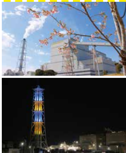
わくわくランドに植樹された河津桜（写真上） 煙突ライトアップ（写真下） 【写真：新地発電所提供】
