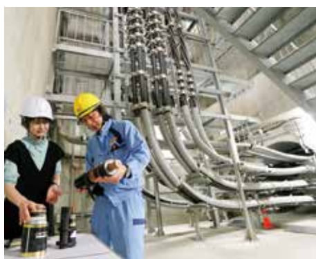
特別高圧の電気を流す送電線は、1.5Lペットボトルくらいの太さ。地下3階よりさらに降りた洞道（写真右下）から立ち上げられ、各装置に接続されます
