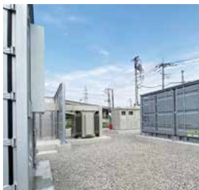
弥藤吾蓄電所(右)・荏塚蓄電所(中央)は出力1,960kW/容量7,460kWh。 小角田蓄電所(左)は出力1,990kW/容量7,400kWh。地域環境に配慮し、防音壁を設置(小角田蓄電所)
