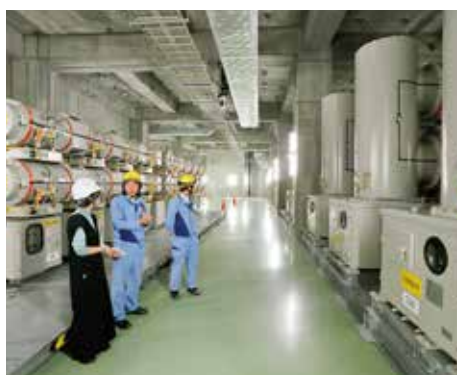
右側に15万4,000V、左側が6万6,000Vの開閉装置（ガス絶縁方式）。この巨大な装置一つひとつが、大きな「スイッチ」の役割を担っています
