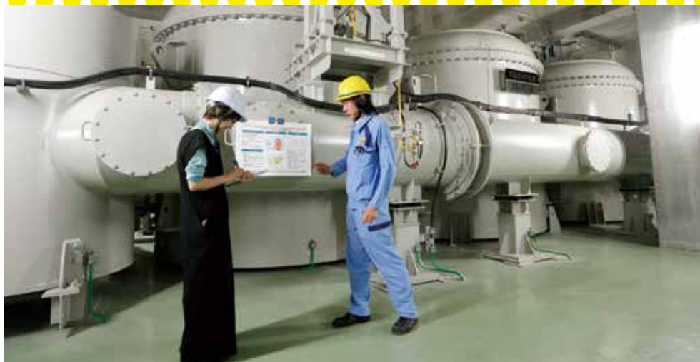
送電線で送られてくる15万4,000Vの特別高圧の電気を6万6,000V、3万3,000Vと段階的に変圧していきます。後ろに見えるタンク状のものが3つで変圧器1つ分。省スペースで安全性に優れたガス絶縁変圧器を採用しています
