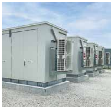
弥藤吾蓄電所(右)・荏塚蓄電所(中央)は出力1,960kW/容量7,460kWh。 小角田蓄電所(左)は出力1,990kW/容量7,400kWh。地域環境に配慮し、防音壁を設置(小角田蓄電所)
