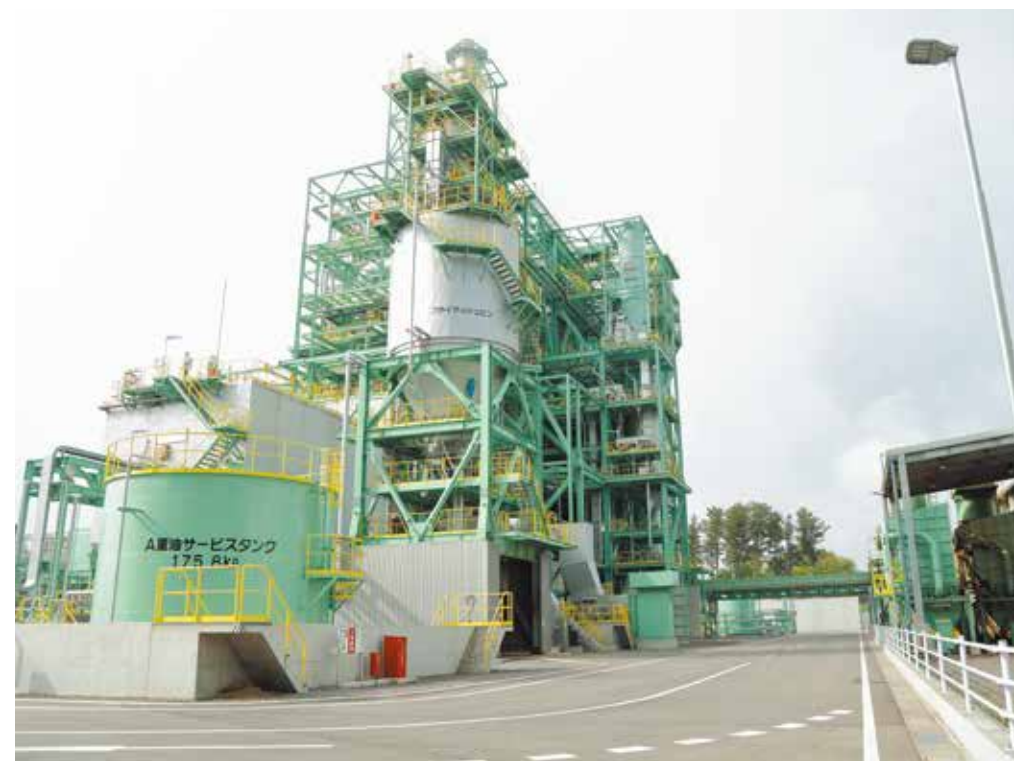
鳥海南バイオマス発電所の高さ約59mのボイラー設備。写真右側には、広さ約1.5haもある燃料(木質ペレット)貯蔵庫が広がっています。
