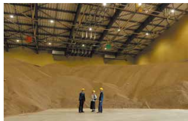
全部で6区画ある巨大な燃料貯蔵庫のうちの1区画。ここには約7,000tの木質ペレットが貯蔵されています。
