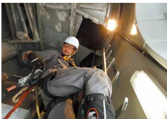
風車タワー内部の点検はハシゴを使いますが、高所では落下のリスクがあるため落下防止用のフルハーネスを装備して慎重に行います。
