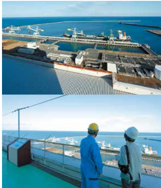
船で運搬されてくる石炭の積み降ろしを行うアンローダーという設備が並びます。1基で1500t/h～1600t/hの荷役能力があるそうです。
