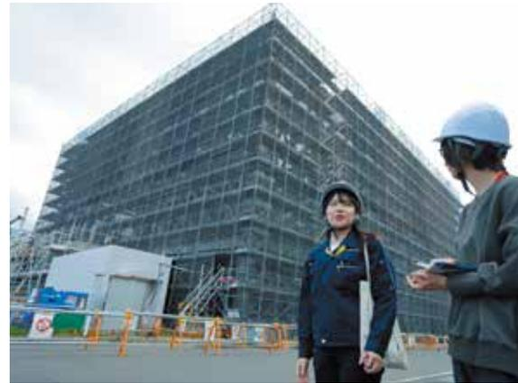
竜巻による飛来物から冷却塔を守るため、飛来物防護ネットを設置する工事中。最大風速100m/秒もの竜巻にも耐えられる対策を行っています。
