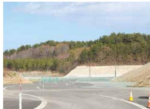
非常時に要員の移動や設備の運搬・敷設に使用するためのアクセスルートが整備されています。写真：日本原燃HPより
