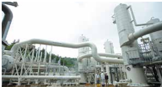
地熱貯留層から取り出された地熱流体は塔のように見える「気水分離器」で熱水と蒸気に分けられます。
