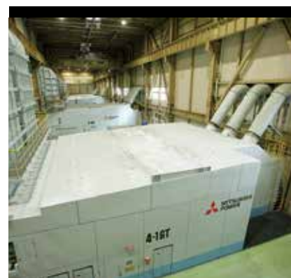
4号系列のガスタービン。フロアには4台のガスタービンが並ぶ。
