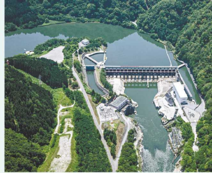
阿賀町豊実にある東北電力(株)豊実ダム。右は豊実発電所で、最大出力は61,800キロワット。左は第二豊実発電所で、最大出力は57,100キロワット
