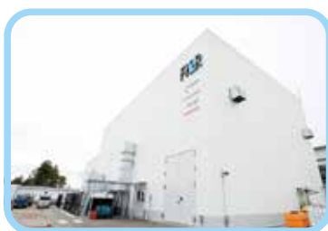
水電解装置が格納されている建屋。太陽光発電からの電力と、東北電力からの系統電力の両方が供給されています。
