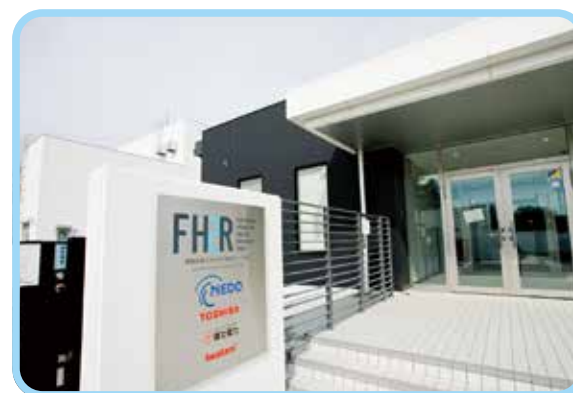
まだ新しい管理棟。この管理棟からフィールド内の発電量や水素製造・貯蔵量を監視し、水素製造量のバランスを調整しています。
