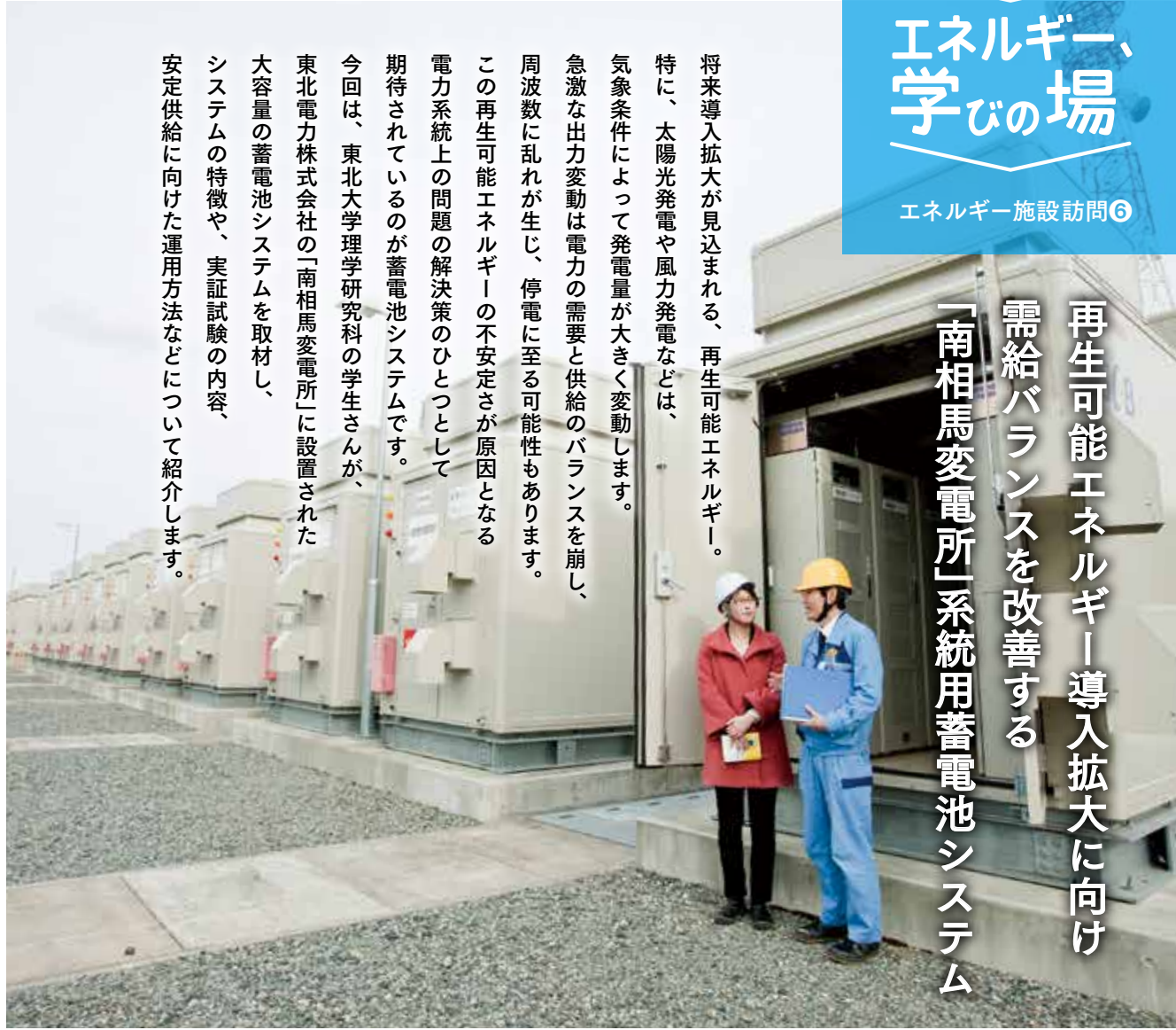
蓄電池コンテナは合計80台。万が一火災が発生した時の延焼防止対策として、各コンテナは金属製の板で仕切られています。
