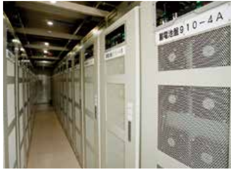
蓄電池システムで利用されているリチウムイオン電池。南相馬変電所では80台の蓄電池コンテナに約109万個のリチウムイオン電池が納められています。
