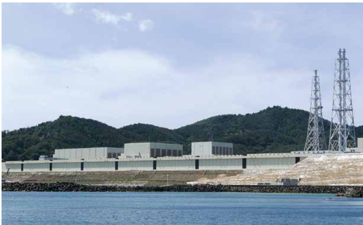
女川原子力発電所防潮堤 (写真提供：東北電力株式会社)
