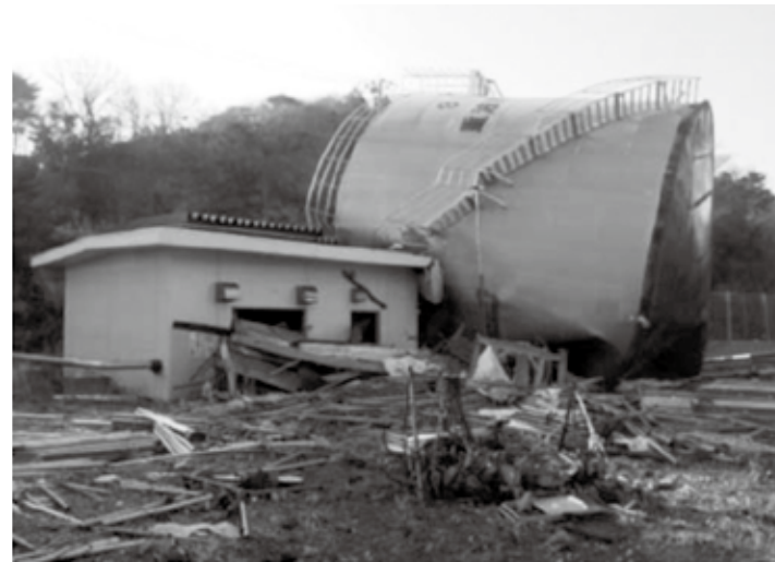
津波で倒れた重油タンク
