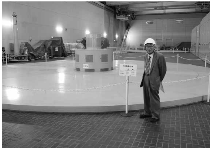
写真③ 発電所本館
