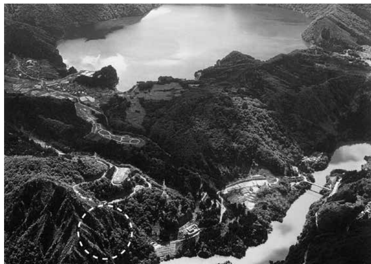
写真① 沼沢湖と第二沼沢発電所 (点線部分の地下にあります)
