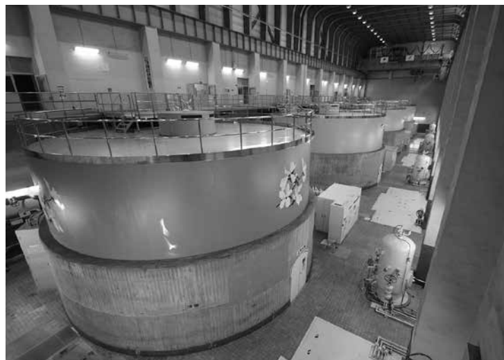
写真⑧ 発電所本館
