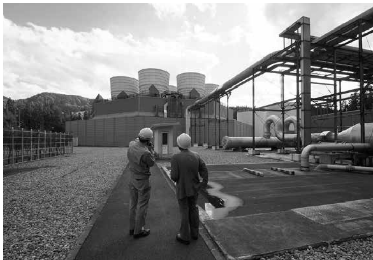
写真⑬ 冷却塔
