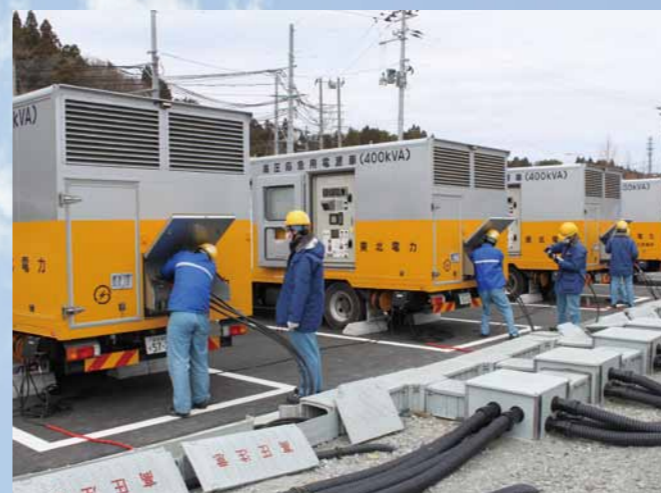
電源車の接続訓練
