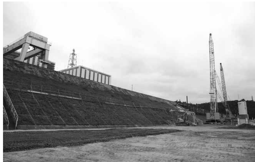
▲防潮堤のかさ上げ工事が進む女川原子力発電所
