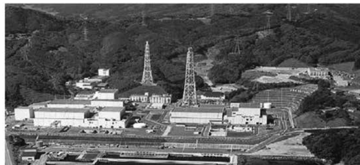
※2号機B系D/GおよびH系D/G(高圧炉心スプレイ)は、その後の津波の影響で使用不可(A系D/Gは使用可能、各号機間での電源融通が可能)
