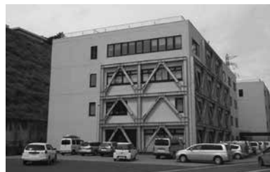
▲耐震補強工事(筋交い)が実施された旧事務棟
