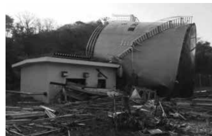
▲倒壊した重油貯蔵タンク(倒壊時の貯油量:約600kl)
