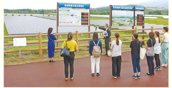
(上)風の丘公園から新潟東部太陽光発電所を眺める参加者の皆さん (下)パネルは積雪の影響を受けないよう、高い位置に設置するといった配慮がされている
