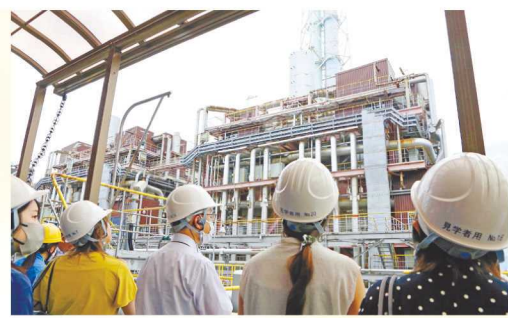
(上)約30mの高さがある排熱回収ボイラー。ガスタービンの排熱で蒸気を発生させている
