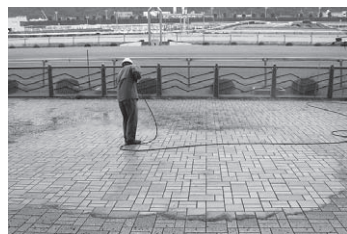
▲スタンド前広場の高圧洗浄
